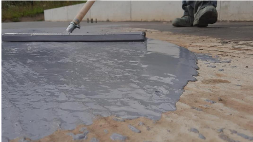
RD Flow Selbstverlaufende, egalisierende Reaktivabdichtung
